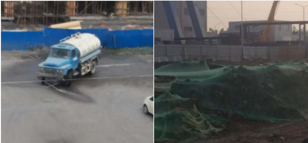
图 5-6 施工期环保措施
